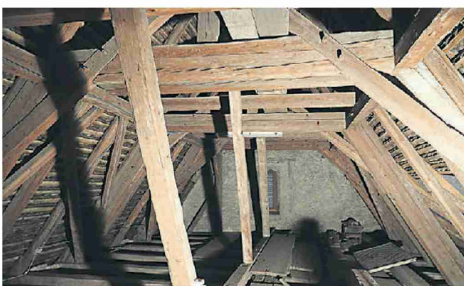
Das alte Dachwerk der Johanniterkapelle muss dringend saniert werden. Teilweise ist das Holz morsch oder verfault. Fotos: vzu
