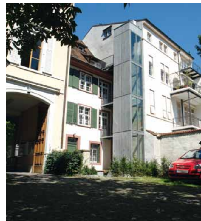
Rückfassade mit Aussenlift
