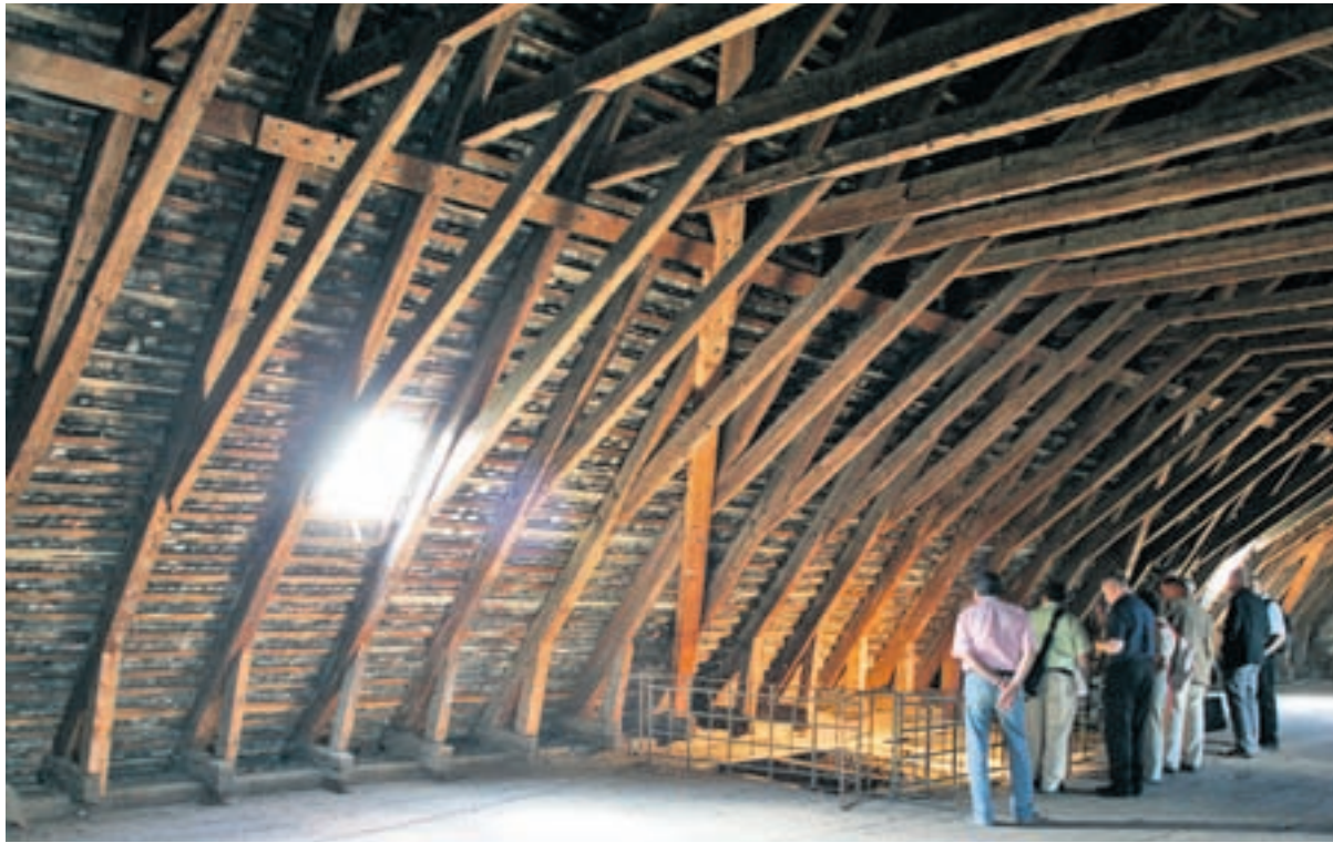
So alt wie die Schweiz. Der Dachstock der Klingentalkirche von 1293 wird sanft restauriert. Foto Henry Muchenberger
