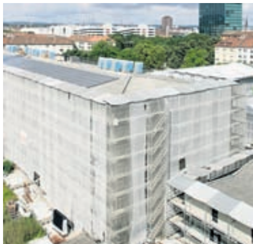
Gewerbeschule. 8000 Quadratmeter Fensterfläche werden ausgewechselt. Foto Henry Muchenberger
