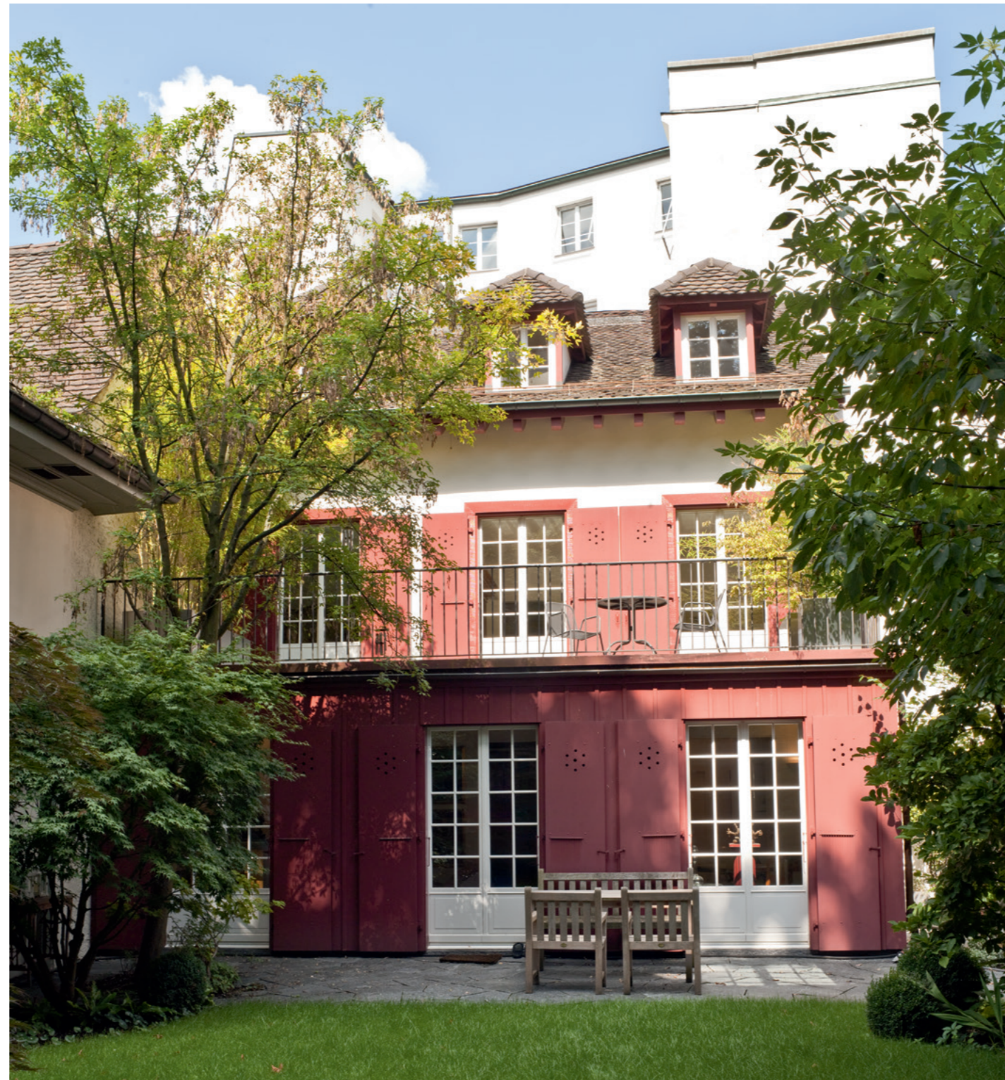
Anbau mit Lattenschalung
