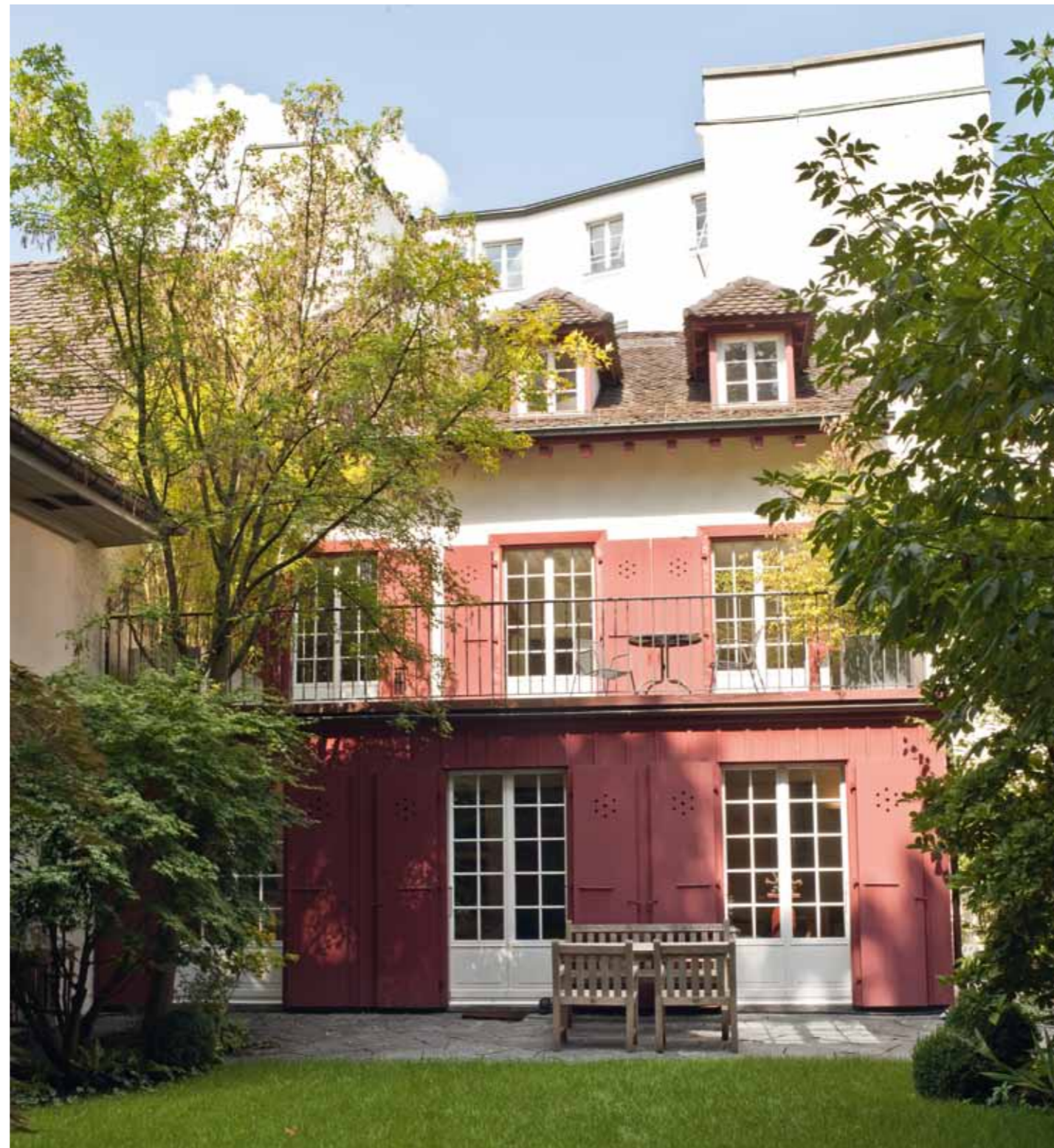
Anbau mit Lattenschalung
