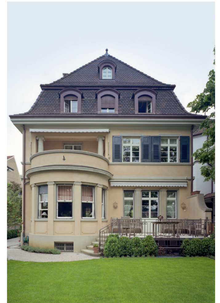
Südfassade mit Terrasse
