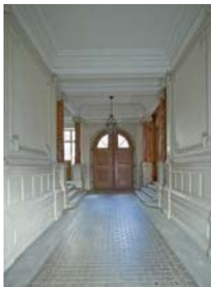
Porte cochère avant la restauration: sous les couches blanches de dispersion se cache un décor somptueux.
