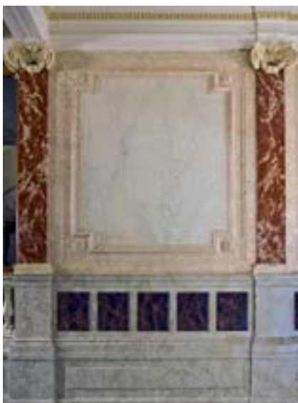
Les parois, les colonnes en faux marbre et les pilastres du passage se distinguent par la richesse des détails décoratifs et leurs coloris subtils.
