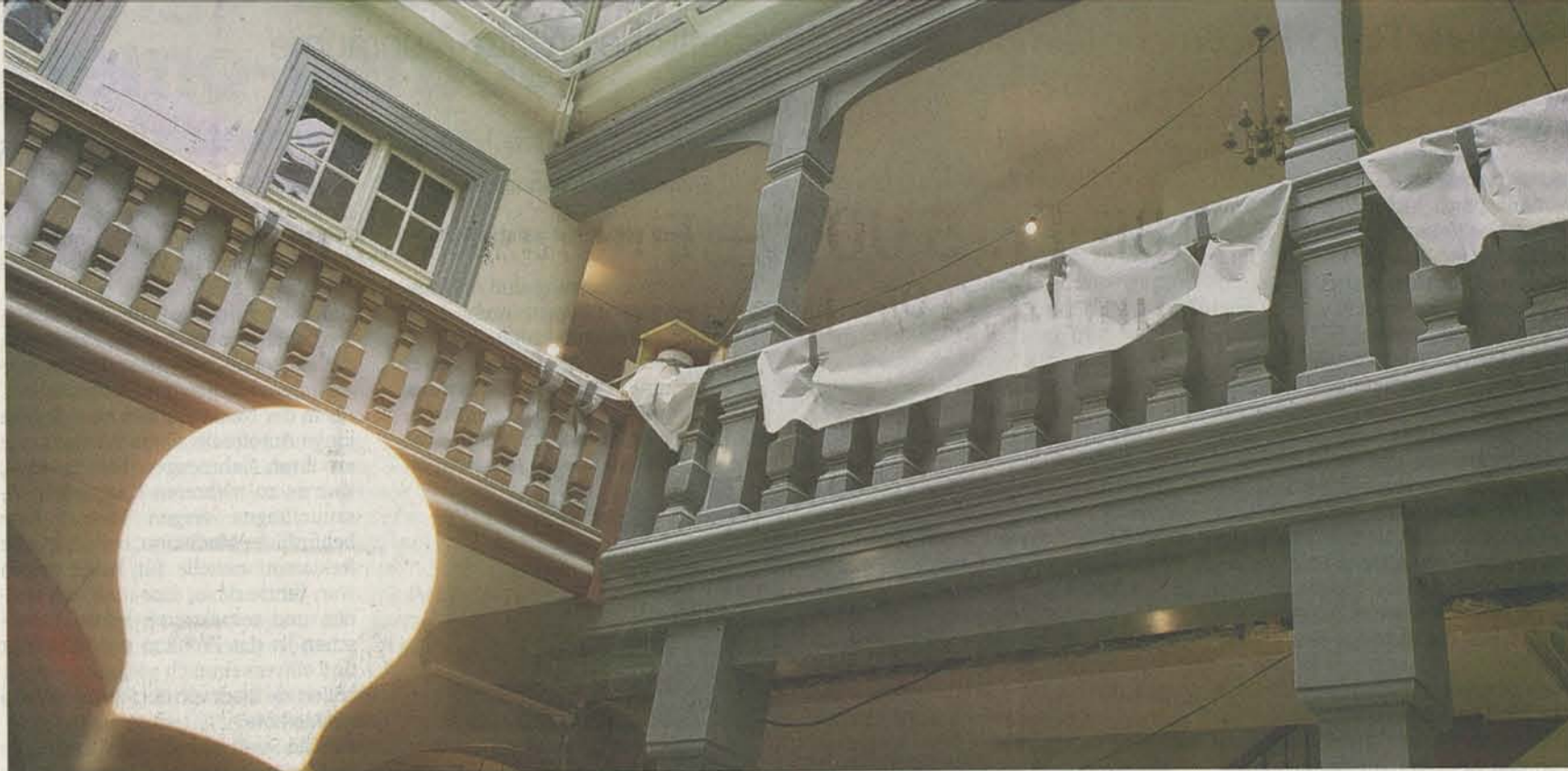
Mehr Licht, mehr Raum. Der Innenhof der Schlüsselzunft wird renoviert und dabei auch grösser und luftiger gemacht. Fotos Henry Muchenberger
