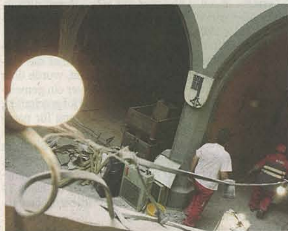
Noch fünf Monate. Bis im Oktober sollen Restaurantsaal (oben) und Hof rundum erneuert sein.
