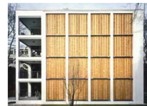
Südfassade Gartenstrasse 80, Läden zu
