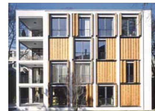
Südfassade Gartenstrasse 80, Läden teilweise offen
