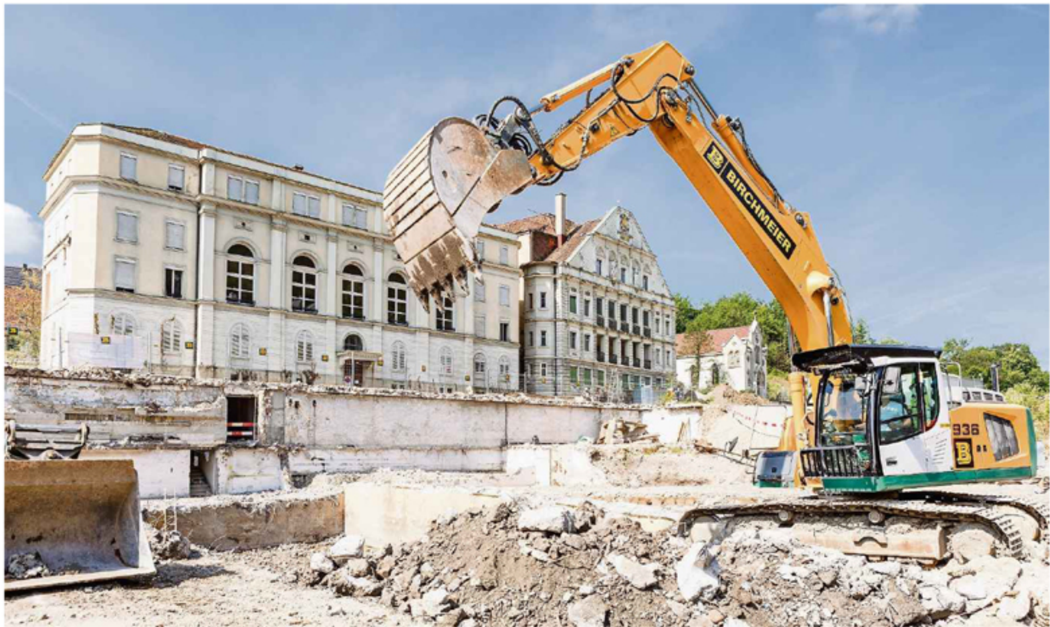
Das Bäderquartier im Wandel: Der Verenaahof (links) und der Bären mit seiner Neurenaissance-Fassade werden bis 2020 umfassend saniert.
