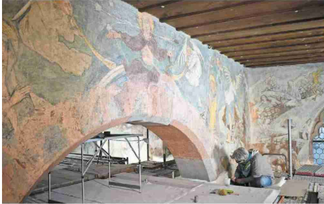
Die Johanniterkapelle in Rheinfelden wird derzeit saniert. Unter anderem werden auch die Wandmalereien von Restauratorinnen und Restauratoren aufwendig restauriert.
