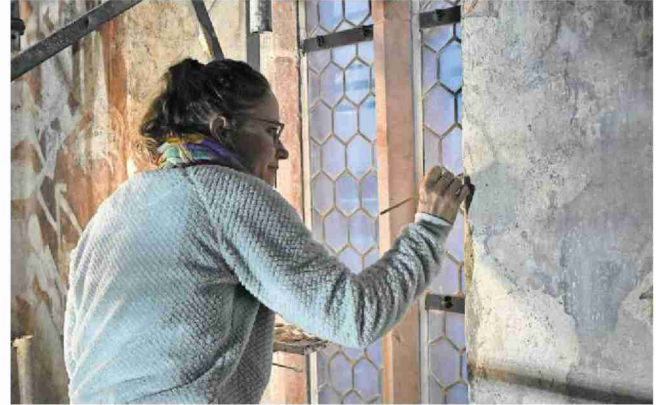
Die Restauratorinnen und Restauratoren füllen die weissen Fehlstellen mit unzähligen Punkten in der richtigen Farbe. Bilder: Nadine Böni (26. Oktober 2022)
