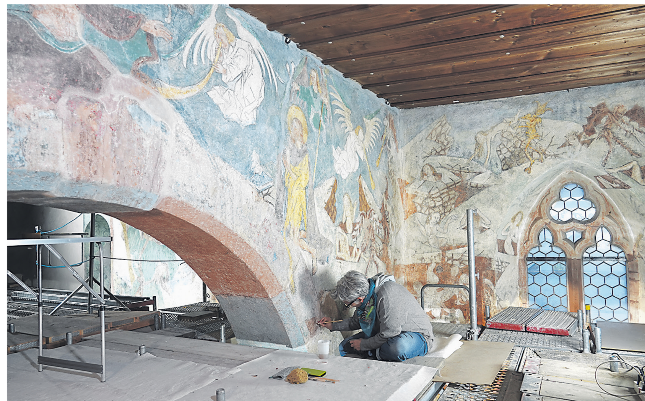
Das Jüngste Gericht: In aufwändiger Arbeit werden die Wandmalereien restauriert. Die Bilder sollen dadurch an Aussagekraft gewinnen.
