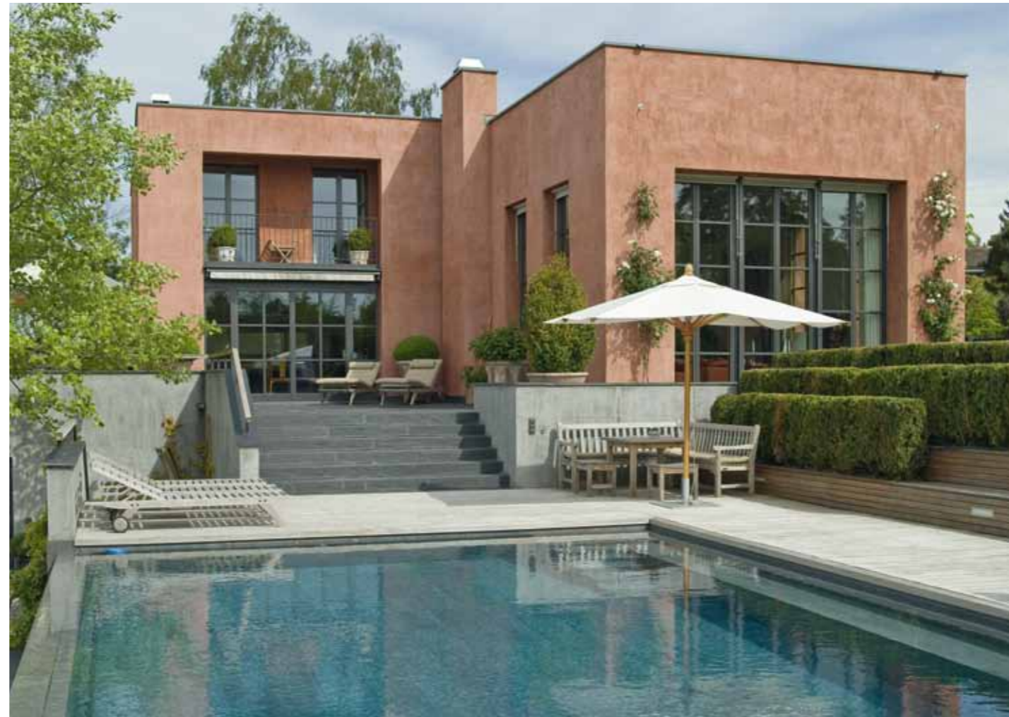
Westfassade mit Overflow-Pool
